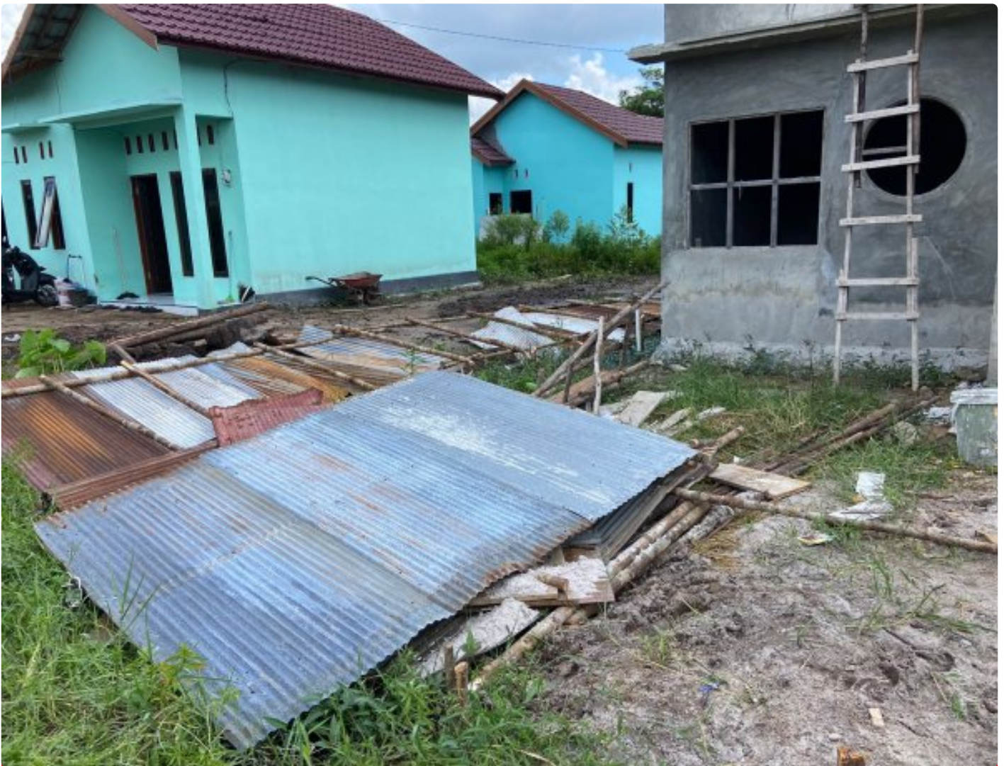
Gambar: Kondisi Pagar Seng Yang Dirusak Oknum
